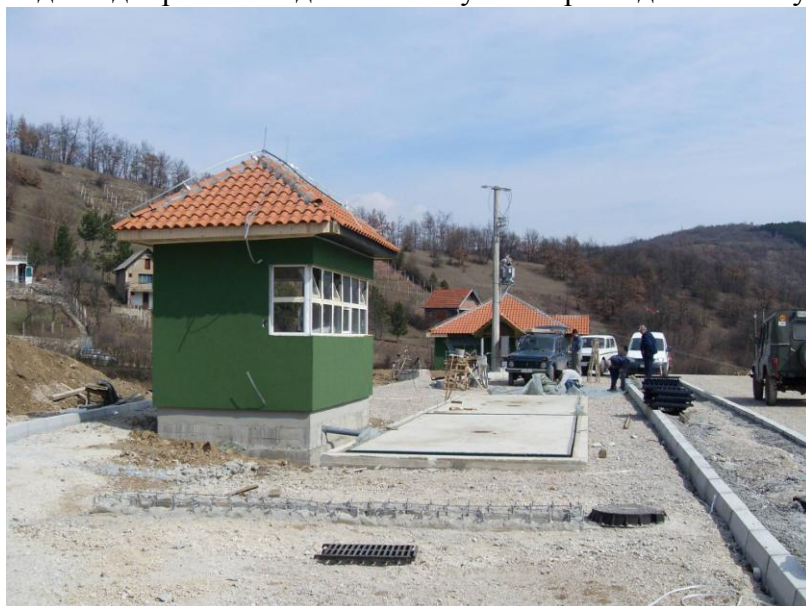
Слика 1.15 Постављање контролне (колске) ваге при изградњи санитарне депоније
