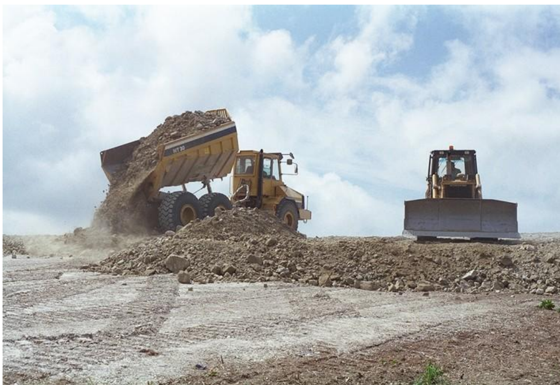
Слика 1.13 Прекривање глином попуњење касете (ћелије) санитарне депоније
