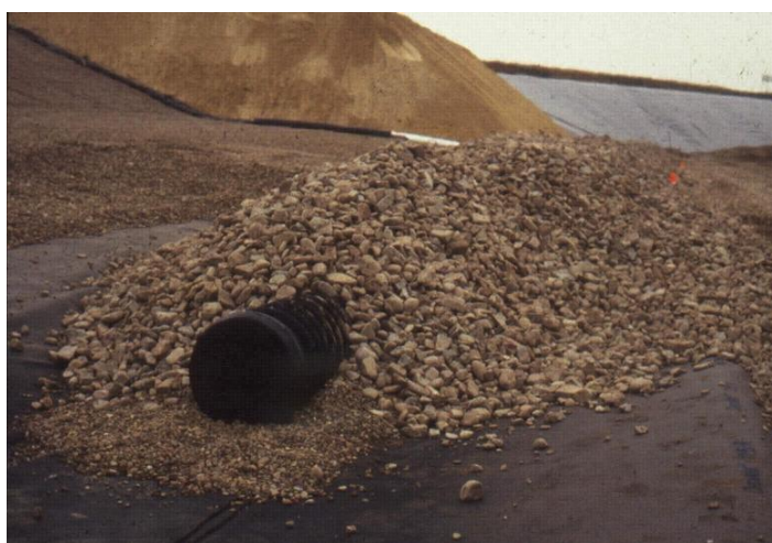
Слика 1.8 Постављање цеви за сакупљање процедне воде у дренажном слоју
