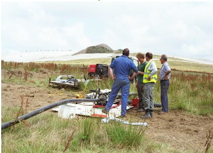
Слика 1.10 Постављање цеви за сакупљање гаса на попуњеној зони санитарне депоније
