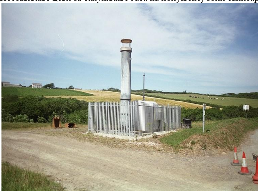
Слика 1.11 Бакља за спаљивање депонијског гаса
