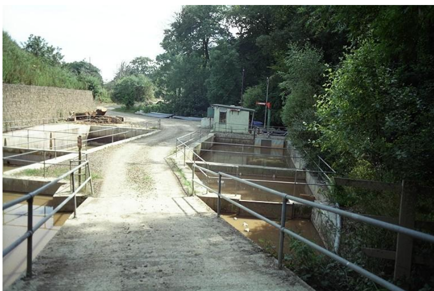
Слика 1.9 Базени за сакупљање (горе) и третман процедних депонијских вода (доле)
