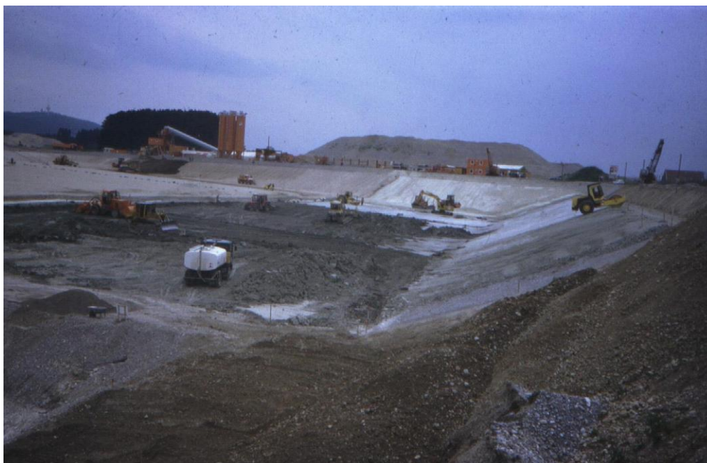
Слика 1.5 Постављање глинене подлоге на санитарној депонији
